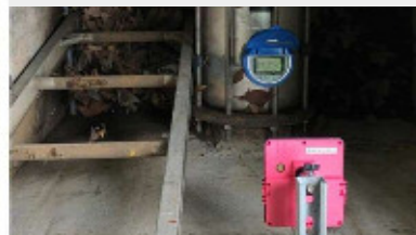
マンホール内
